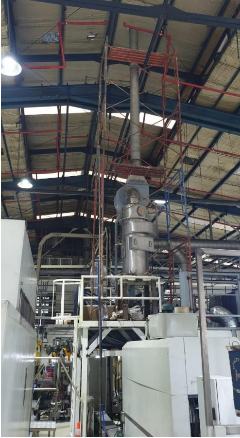
PEMASANGAN DAN PENGADAAN BLOWER
