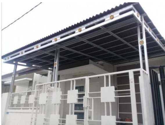
PEMASANGAN KANOPI MINIMALIS
