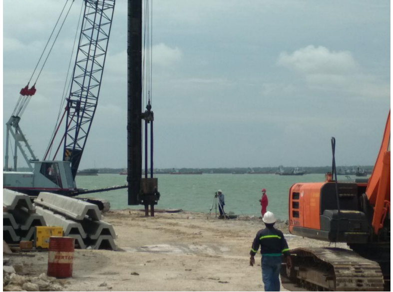
PEMANCANGAN SITE PILE
