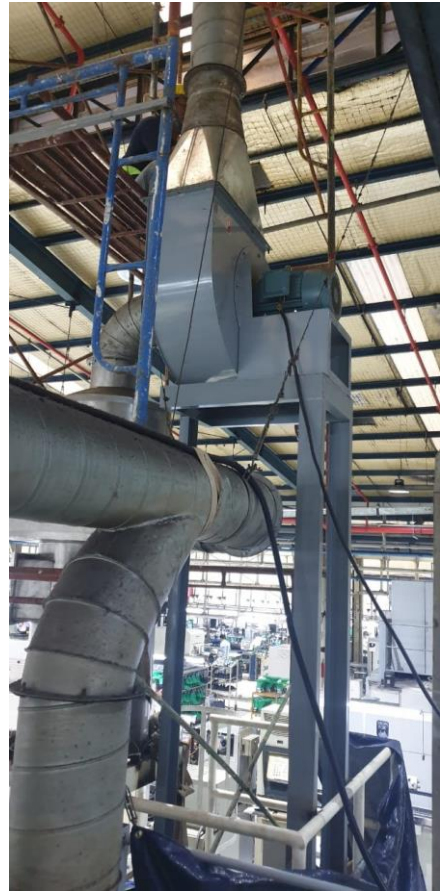
PEMASANGAN DUCTING BJLS
