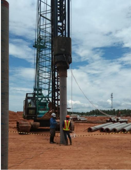
PEMANCANGAN SPOON PILE
