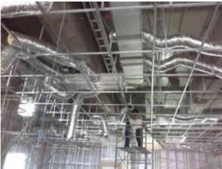
PEMASANGAN DUCTING PU
