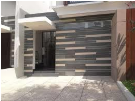
PEMASANGAN BATU ALAM
