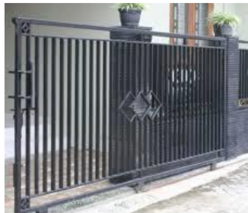
PEMASANGAN PAGAR MINIMALIS
