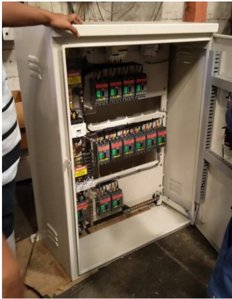
PEMBUATAN PANEL POWER, ATS DLL
