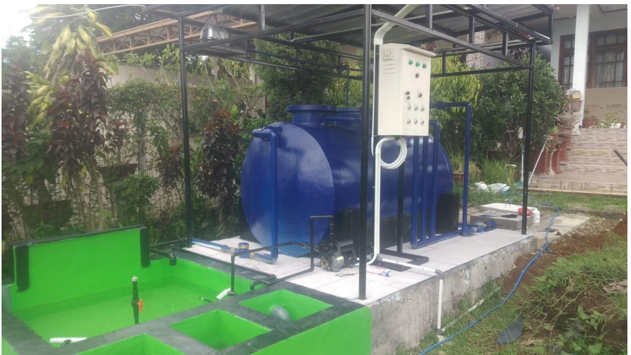
PEMASANGAN ALAT IPAL BIO MEMBRANE
