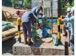
Proses memasukkan Coke Breeze ke Deepwell
