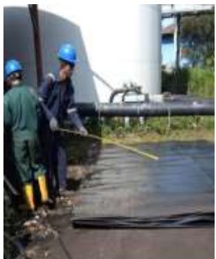
Apr 2022 - HDPE System for Jetty Pile - PT Bukit Asam di Dermaga Tarahan, Bandar Lampung
