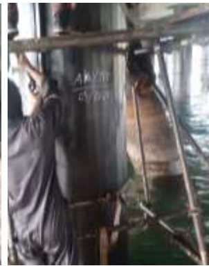
Apr 2022 - HDPE System for Jetty Pile - PT Bukit Asam di Dermaga Tarahan, Bandar Lampung
