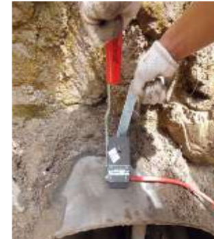
Februari 2015 - Supply Material Sacrificial Magnesium Anode for Pipeline - PT. Perusahaan Gas Negara, Tambak Lorok, Semarang, Jateng
