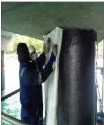
Jun 2017 - Composite Wrapping 2000 micron for Jetty Pile - PLTU Pacitan, Jawa Timur
