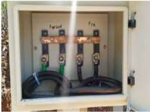
Terminasi kabel negative
