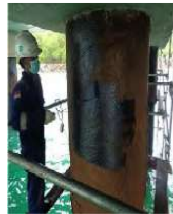
Jun 2017 - Composite Wrapping 2000 micron for Jetty Pile - PLTU Pacitan, Jawa Timur
