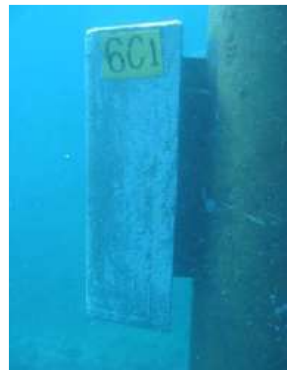
2009 - Sacrificial Aluminium Anode for Jetty Pile - PLTU Lampung 2 x 100 MW, Tanjung Selaki, Lampung
