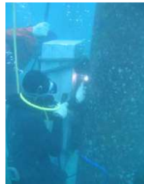
2009 - Sacrificial Aluminium Anode for Jetty Pile - PLTU Lampung 2 x 100 MW, Tanjung Selaki, Lampung
