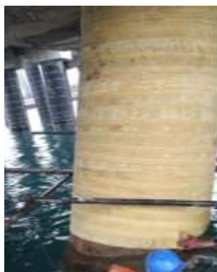
Apr 2022 - HDPE System for Jetty Pile - PT Bukit Asam di Dermaga Tarahan, Bandar Lampung
