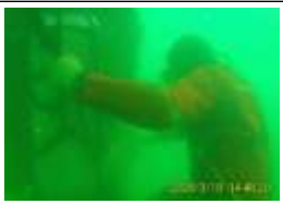
Proses menempatkan posisi anoda di pile sampai pengelasan
