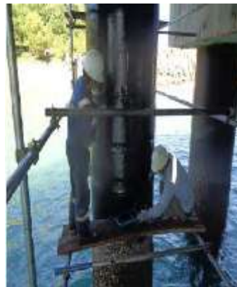
Jun 2017 - Composite Wrapping 2000 micron for Jetty Pile - PLTU Pacitan, Jawa Timur
