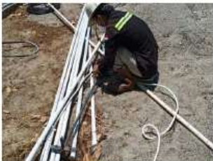
Fabrikasi PVC vent pipe
