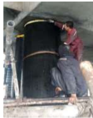
Apr 2022 - HDPE System for Jetty Pile - PT Bukit Asam di Dermaga Tarahan, Bandar Lampung
