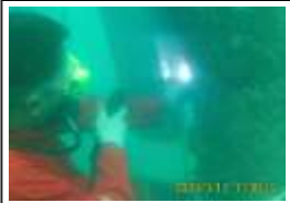
Pengelasan Anoda (Pull Weld)
