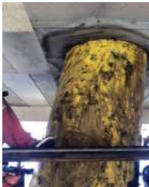
Apr 2022 - HDPE System for Jetty Pile - PT Bukit Asam di Dermaga Tarahan, Bandar Lampung
