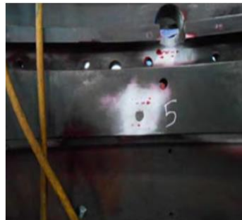
PERBAIKAN LUBANG BAUT TURBINE CASING GTG 2.3 UBP (TAMBAK LOROK)
