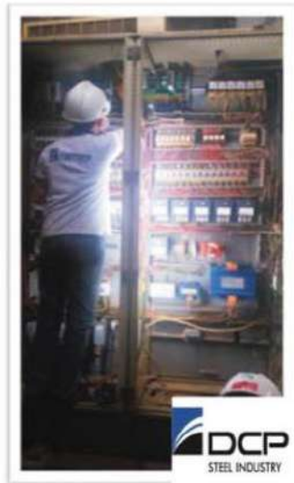
Pemasangan Kontrol sistem Galvanize pada PT. Dutacipta Pakarperkasa
