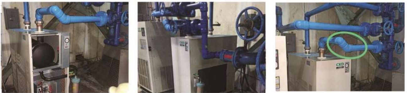
Instalasi dryer refrigerant di PLTU PT. PJB Gresik
