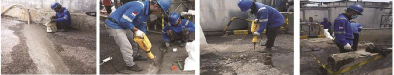
Pemasangan Pipa Air Garam Area Fermentasi PT. ANUGRAH MUTU BERSAMA (AMB)
