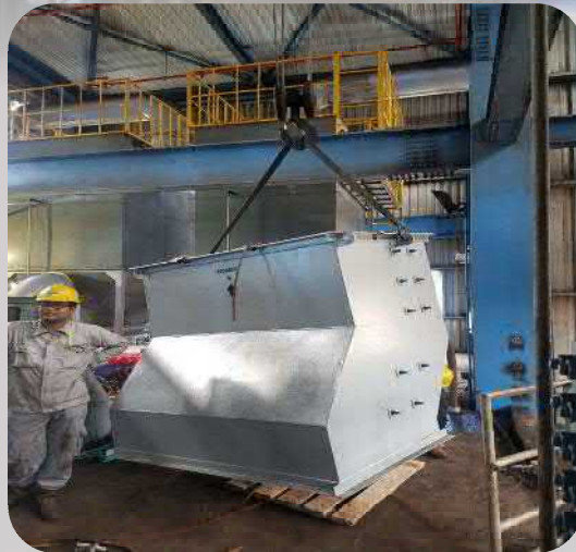
MODIFIKASI CHUTE BY PASS PLTU PACITAN 2 X 315 MW (PT. PJB UBJOM PLTU PACITAN, PACITAN) 2017
