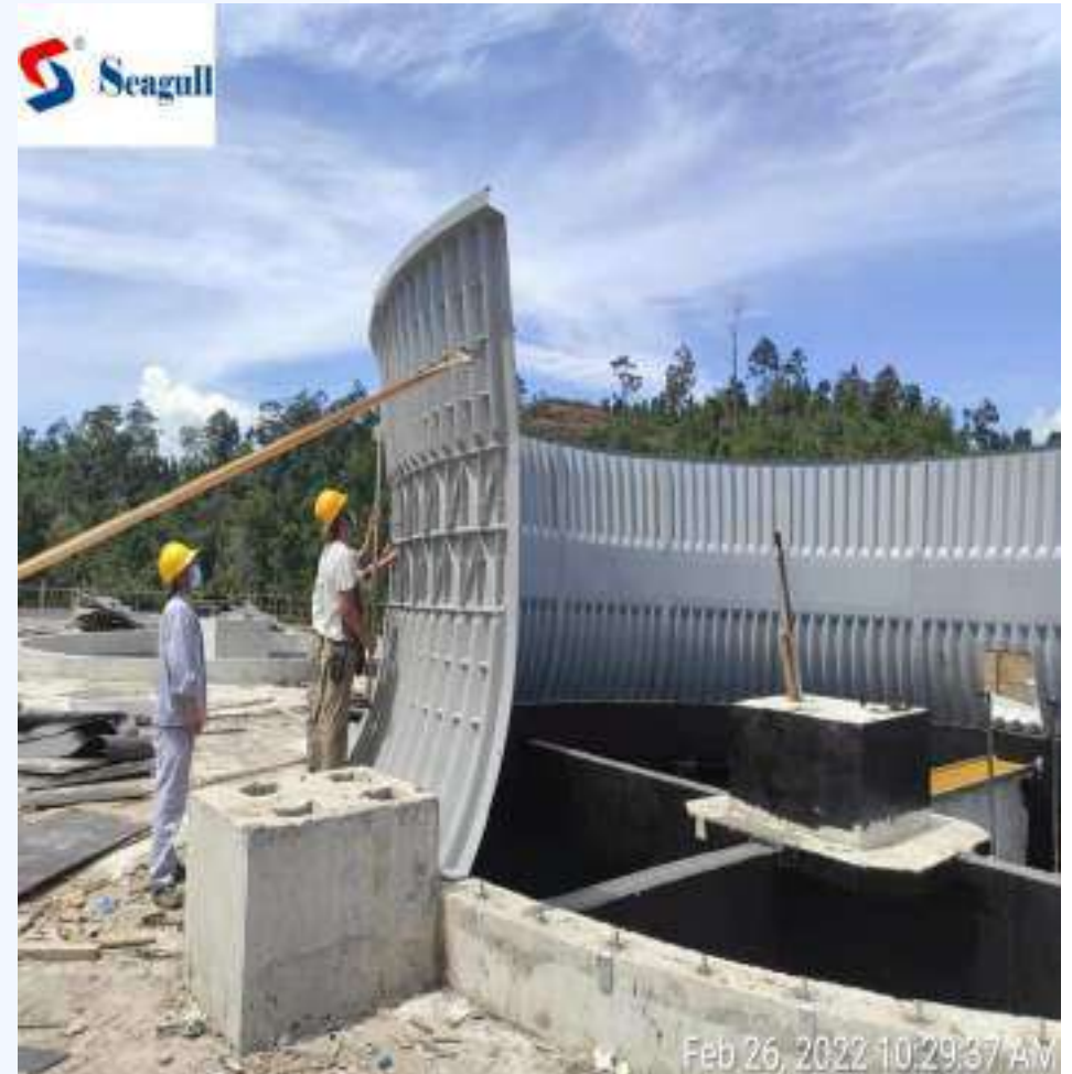
Fan stack installation
